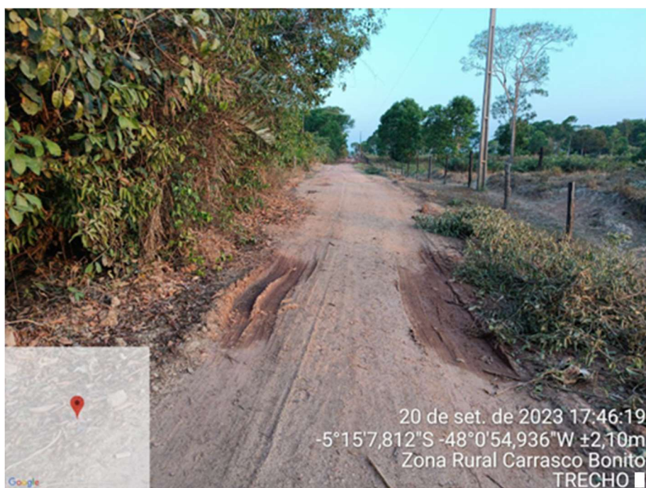
FOTO 14: TRECHO 2 IMPLANTAÇÃO BSTC 2
