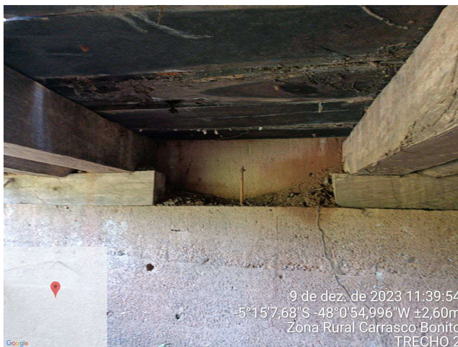
FOTO 10: TRECHO 2 IMPLANTAÇÃO DE PTCP 1
