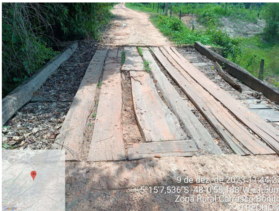
FOTO 5: TRECHO 2 IMPLANTAÇÃO DE PTCP 1
