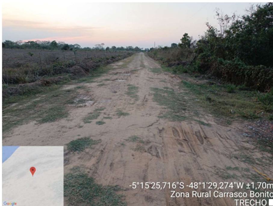
FOTO 1: TRECHO 1 IMPLANTAÇÃO DE BSTC 1
