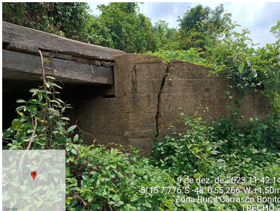
FOTO 8: TRECHO 2 IMPLANTAÇÃO DE PTCP 1
