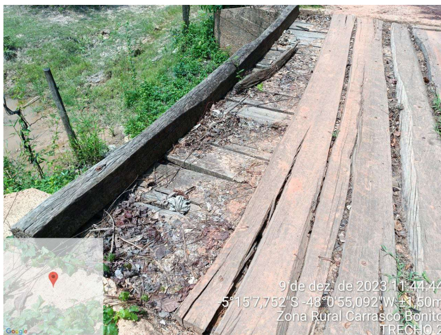
FOTO 7: TRECHO 2 IMPLANTAÇÃO DE PTCP 1
