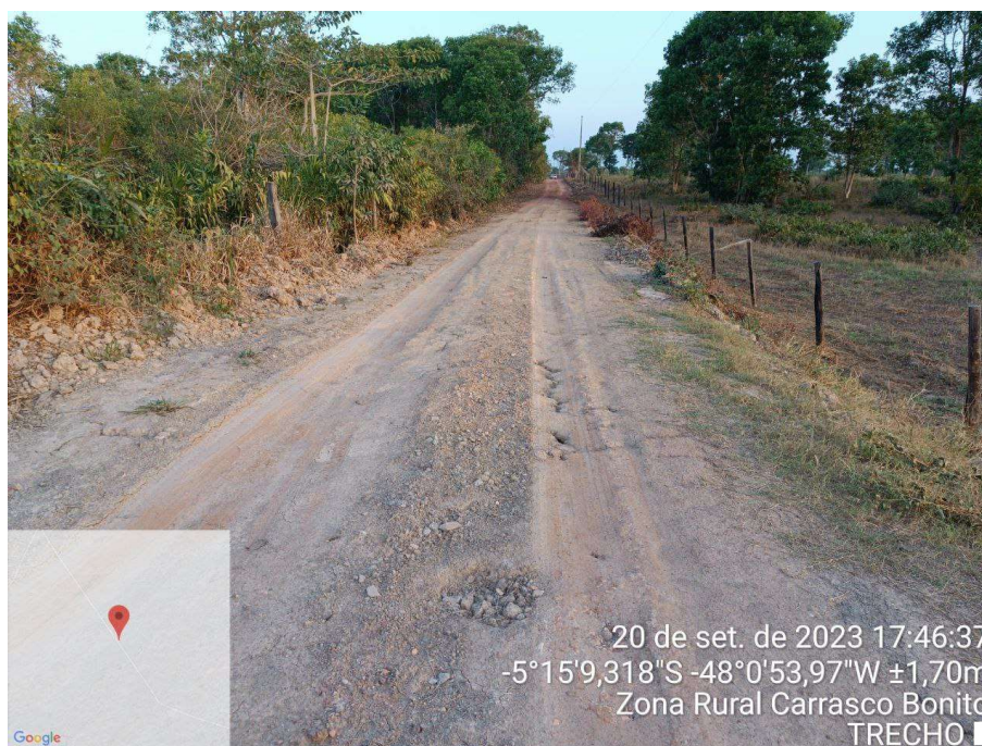
FOTO 13: TRECHO 2 IMPLANTAÇÃO BSTC 2
