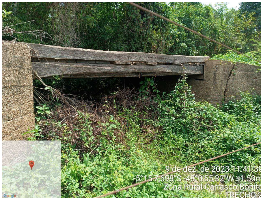
FOTO 9: TRECHO 2 IMPLANTAÇÃO DE PTCP 1
