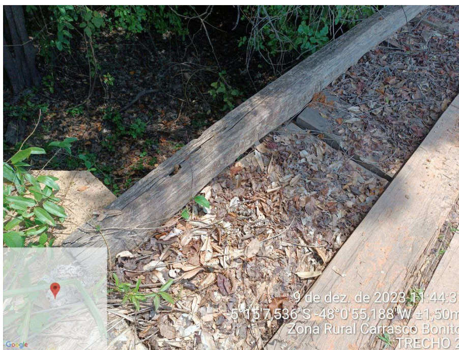
FOTO 6: TRECHO 2 IMPLANTAÇÃO DE PTCP 1
