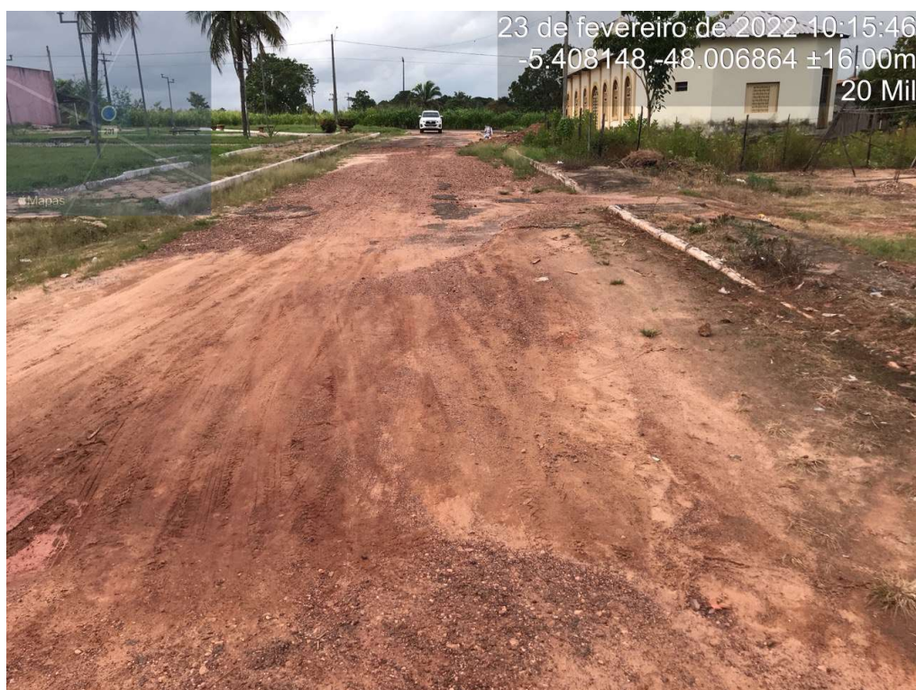
Foto 12: Rua da Igreja (Trecho 4)
