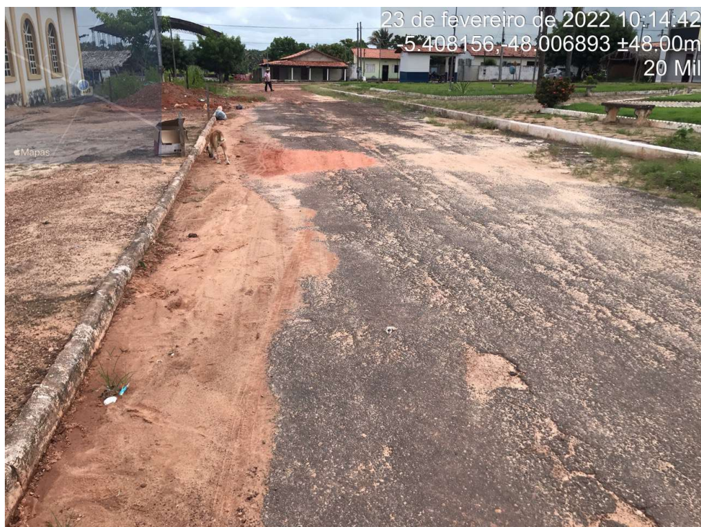
Foto 11: Rua da Igreja (Trecho 4)
