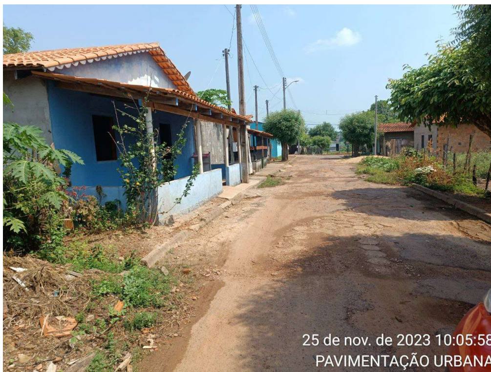
Foto 10: Rua C (Trecho 3)
