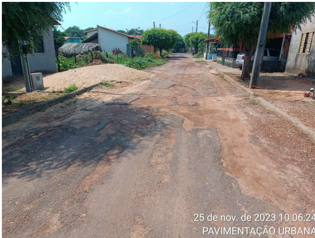
Foto 9: Rua C (Trecho 3)
