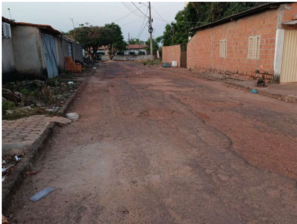
Foto 15: (Rua da Escola Trecho 6)
