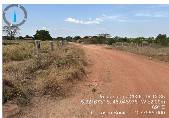
IMG 11 - FIM (RUA SÃO SEBASTIÃO) -5.321672, -48.043975
