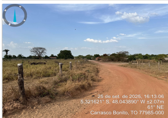
IMG 9 - FIM (RUA SÃO SEBASTIÃO) -5.321619, -48.043889
