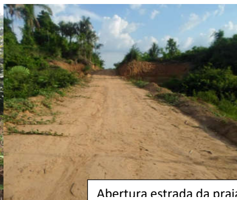
Abertura estrada da praia (antes)
